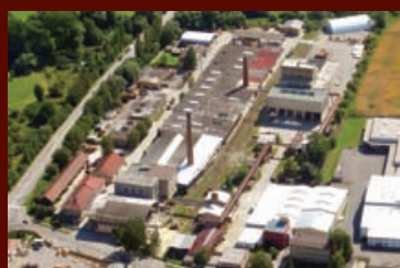
PLANT 01 MKZ FIRECLAY FACTORY ZÁVOD 01 MKZ ŠAMOTKA
